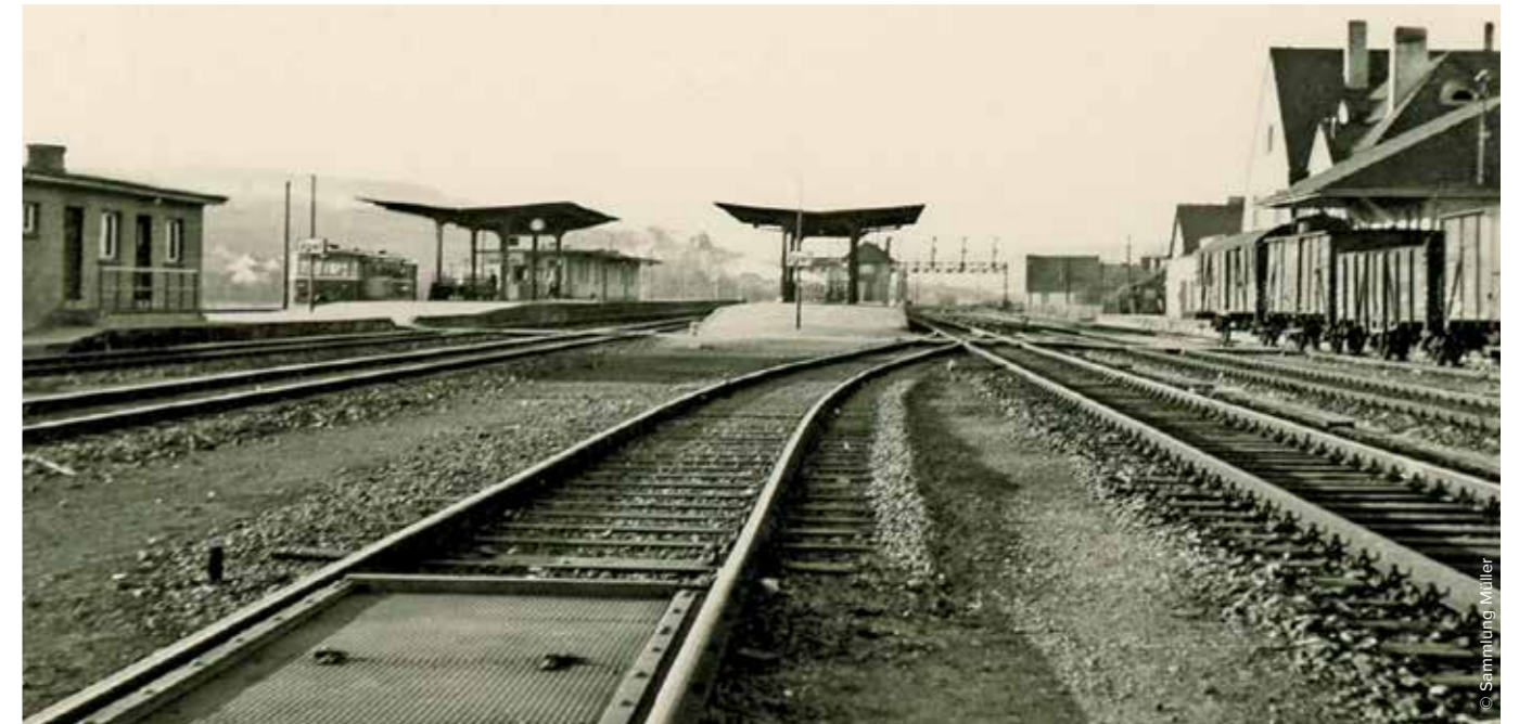
Gleisanlagen mit verschiedenen Gebäuden Igel / Blick Richtung Wasserbillig
