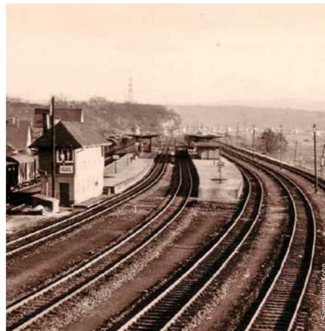
Gleisanlagen mit verschiedenen Gebäuden Igel / Blick Richtung Ehrang
