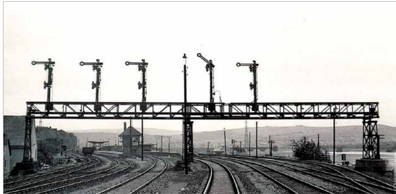
Signalbrücke Igel / Blick Richtung Ehrang / Stellwerk und verschiedene Gebäude
