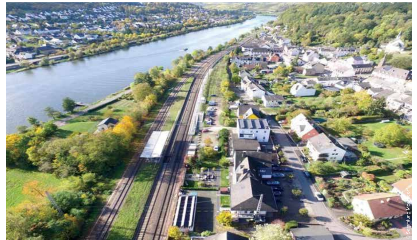
Bahnhof Igel / Heutiger Zustand
