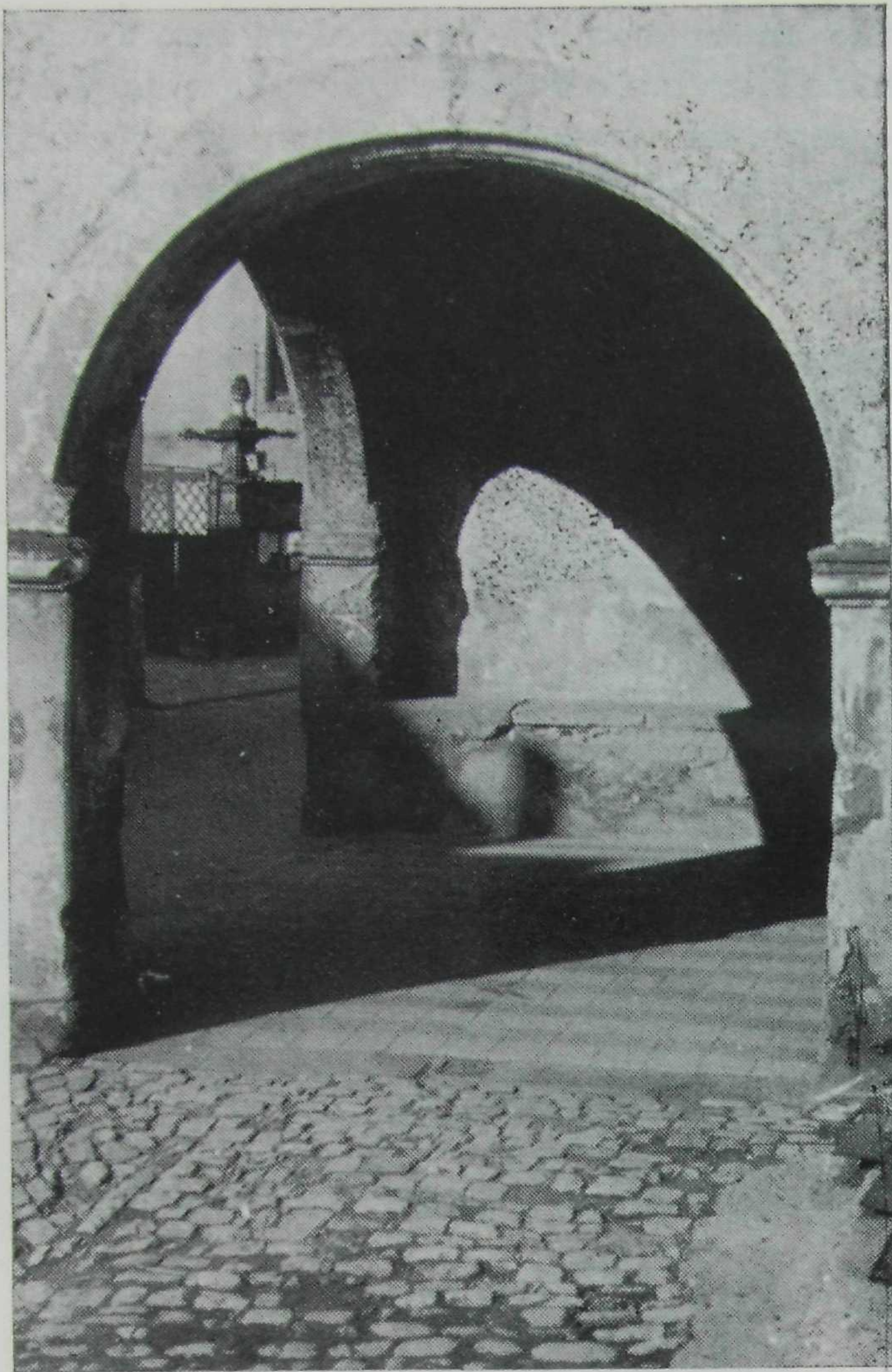
Blick in die Gerichtslaube (Steinlaube) vom Hof des Steinlaubenhauses aus
